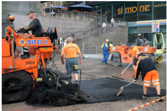
Kuva: Hannu Lehto ASFALTTITYÖ
